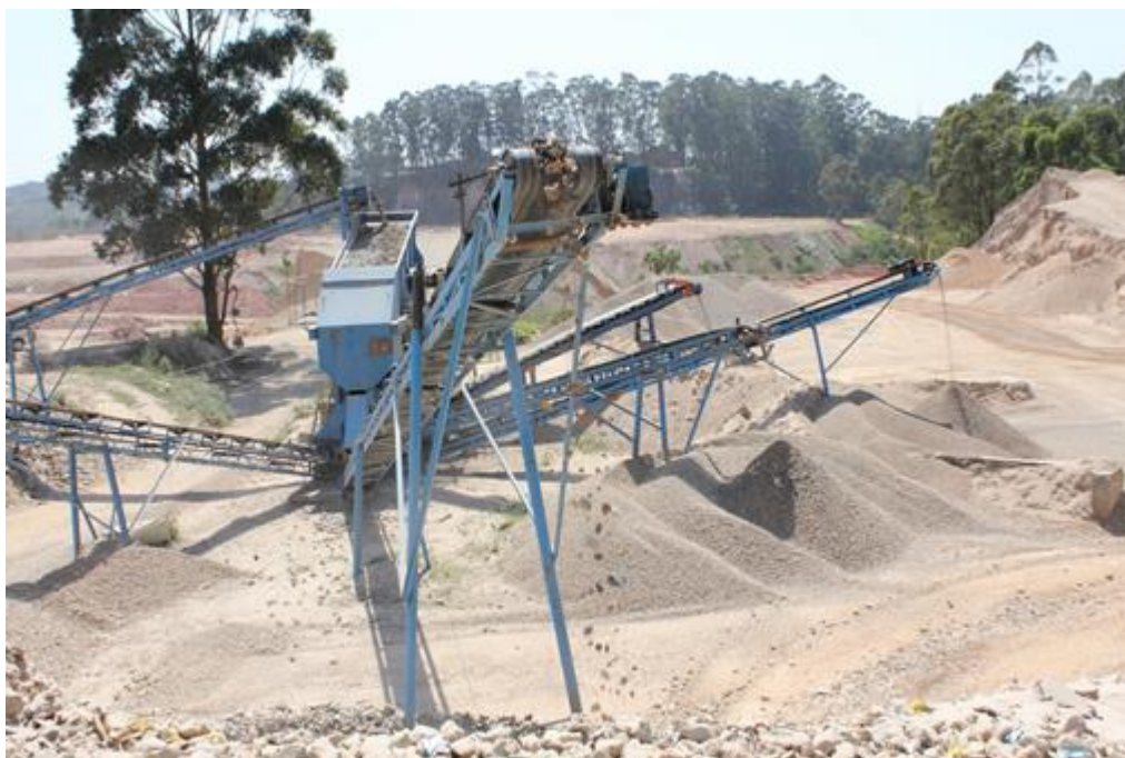
Figura: Usina de Reciclagem de Entulhos
